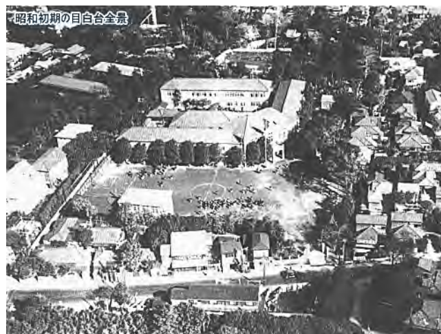
昭和初期からの校舎、下部の道路は「目白通り」
